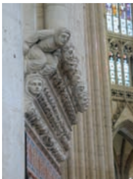
Culots de l'encorbellement de la pile nord-ouest de la croisée (Arch. dép. de l'Orne)
