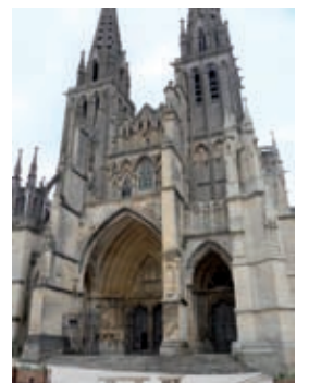
Façade occidentale, état actuel (Arch. dép. de l'Orne)
