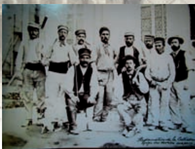
Restauration de la cathédrale. Les ouvriers maçons, vers 1895. (déch. Guerthais, Arch. dép. de l'Orne)
