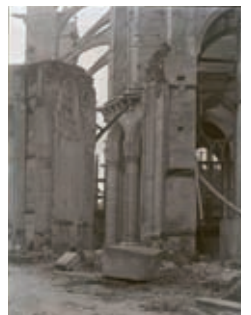
Le chœur de la cathédrale en travaux, vers 1890 (Arch. dép. de l'Orne)
